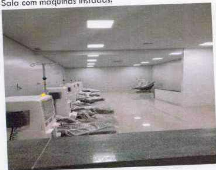
Sala com maquinas instaladas:
