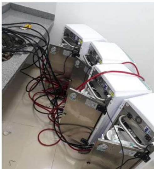
Instalação da Casa de Máquinas da Hemodiálise
