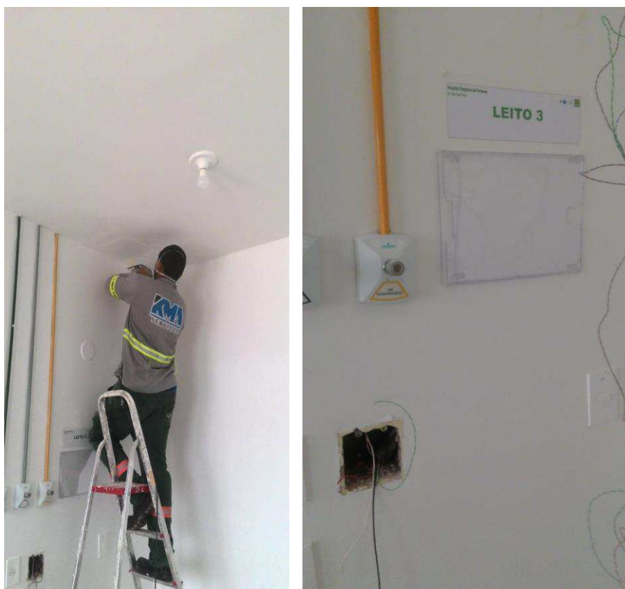
Figura 4. Funcionário cortando o gesso para passagem dos fios e fio passado respectivamente.
