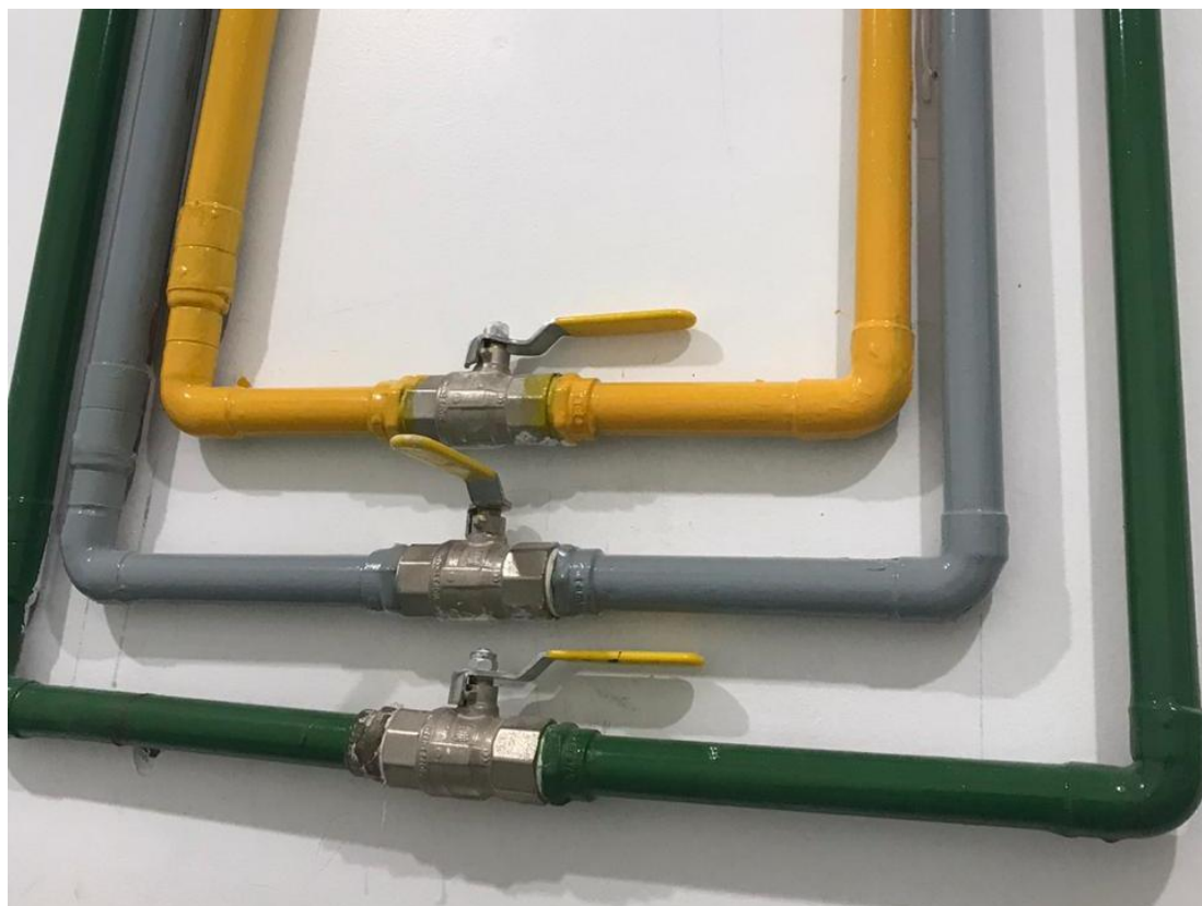
Testes iniciais do ar-comprimido.
