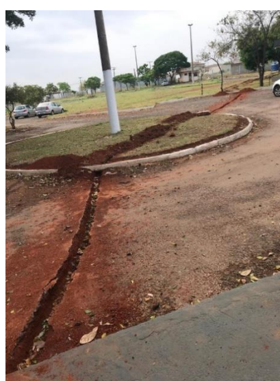
ESCAVAÇÕES PARA PASSAGEM DE INSTALAÇÕES ELÉTRICAS E HIDRÁULICAS.
