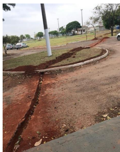
ESCAVAÇÕES PARA PASSAGEM DE INSTALAÇÕES ELÉTRICAS E HIDRÁULICAS.
