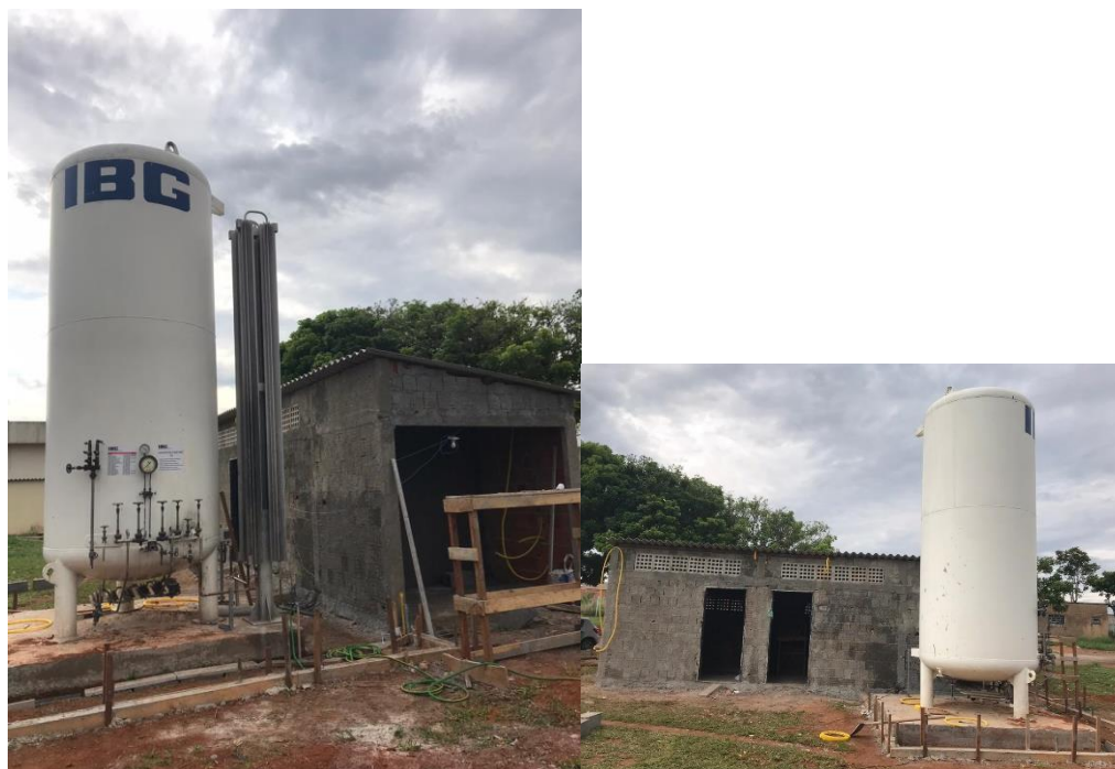
Acompanhamento da construção dos abrigo.
