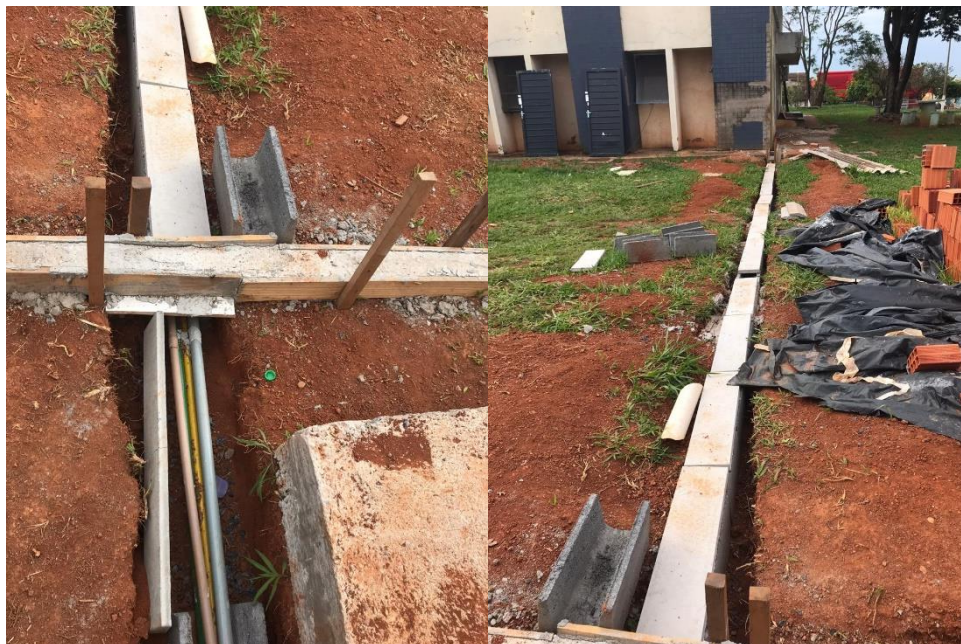
Instalação de canaleta em concreto com tampa para a passagem de tubulação de gases medicinais.
