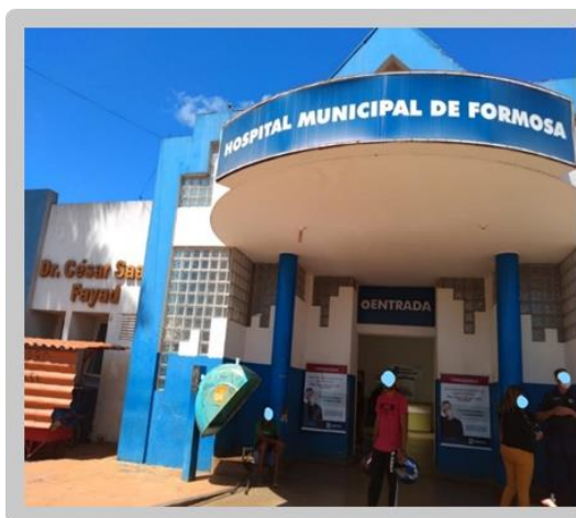
c) Pintura interna e externa da fachada principal
