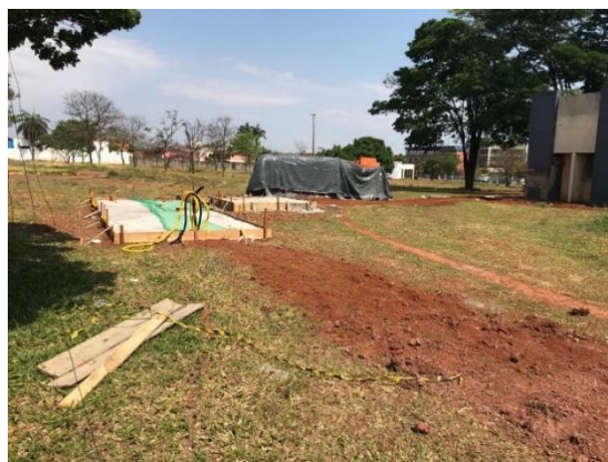
Início da construção das bases para o tanque e abrigos.
