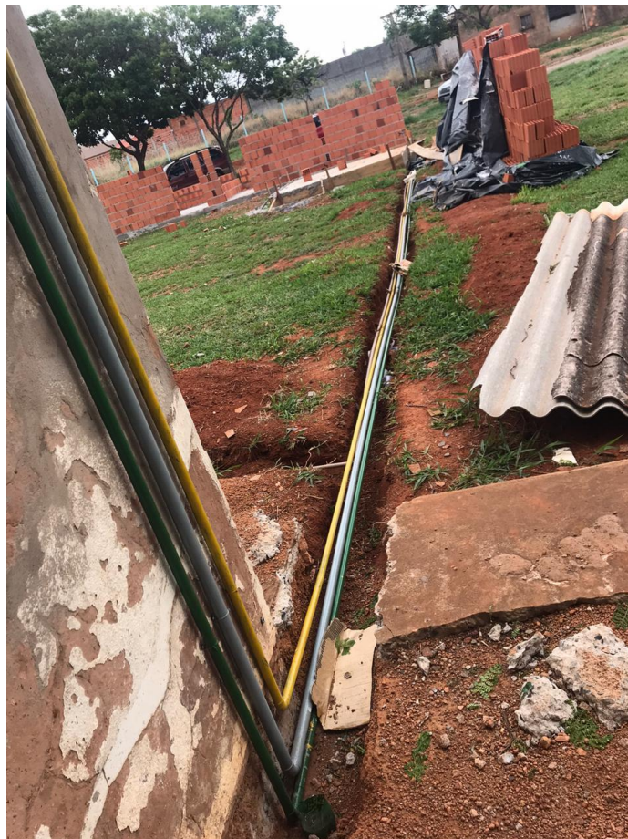
Passagem de tubulações.
