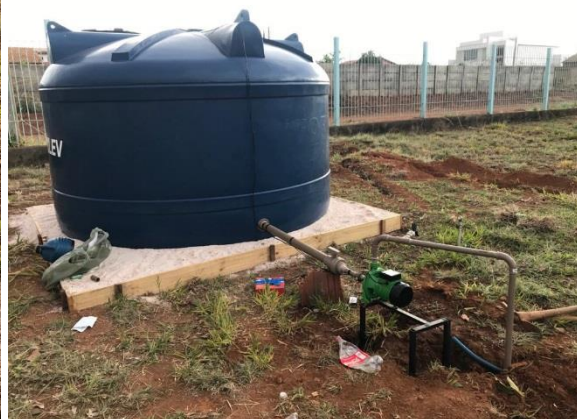
INSTALAÇÃO DE CAIXA D'ÁGUA DE 10.000 LITROS E SISTEMA DE PRESSURIZAÇÃO.
