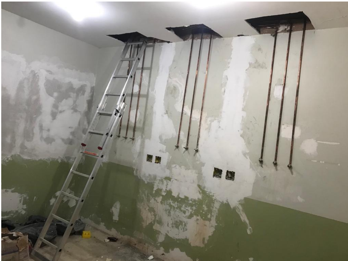
Passagem de tubulações e instalação de pontos em enfermarias.
