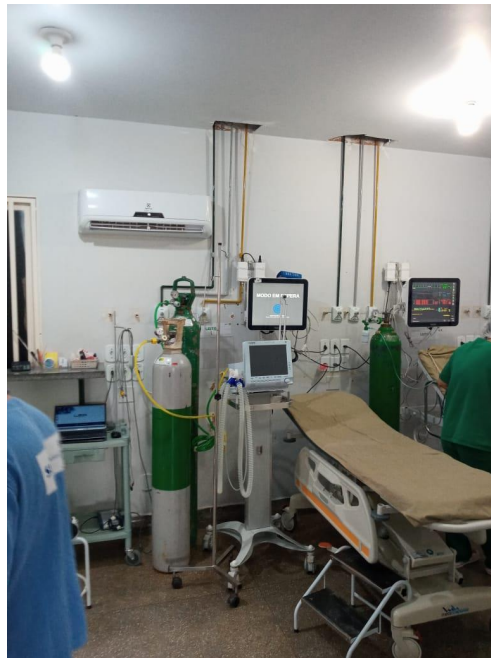
IMAGEM 01: Ampliação da rede de gases medicinais canalizados em enfermarias e sala vermelha do pronto-socorro.
