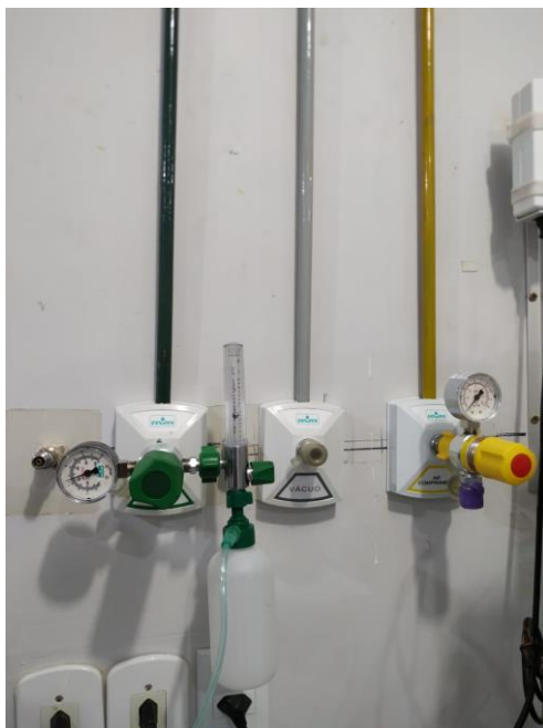
IMAGEM 01: Ampliação da rede de gases medicinais canalizados em enfermarias e sala vermelha do pronto-socorro.
