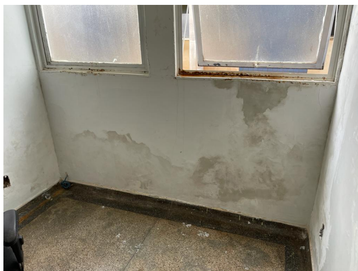
Isolamento de janelas do corredor central.
