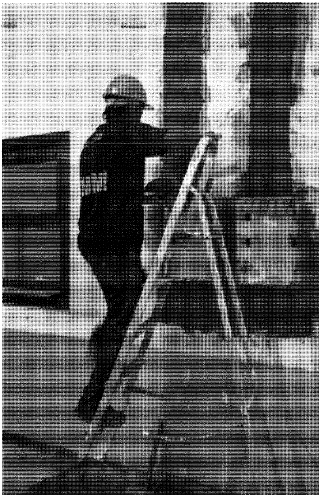
ADEQUAÇÃO DE ESPAÇO EXISTENTE PARA ENFERMARIA CIRÚRGICA
