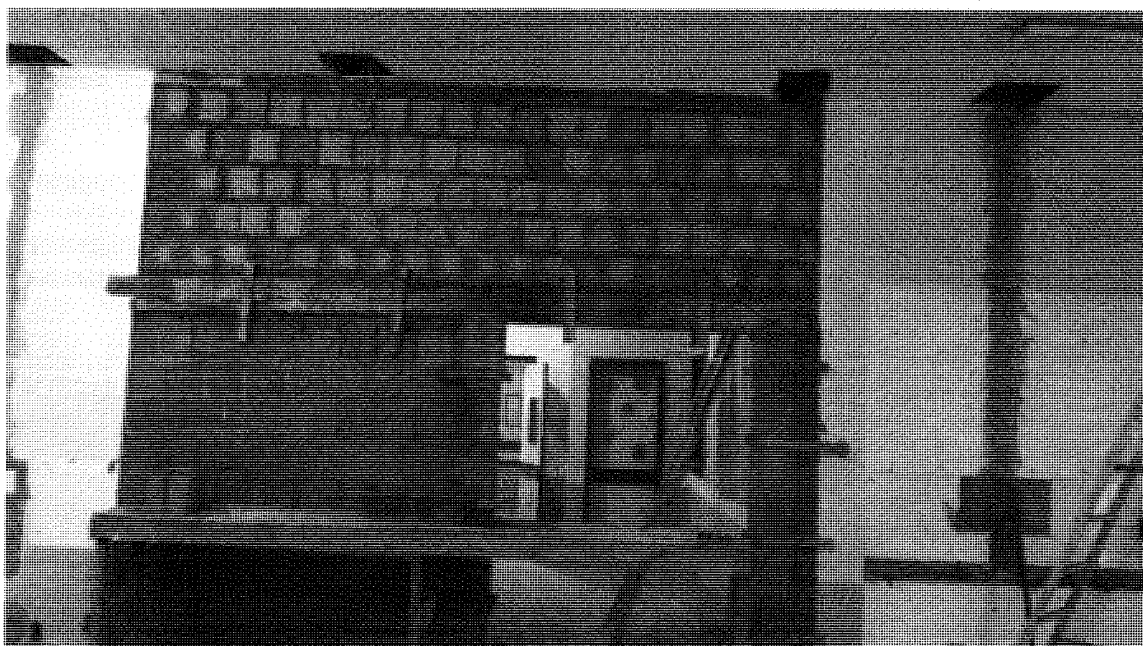
ADEQUAÇÃO DE ESPAÇO EXISTENTE PARA ENFERMARIA CIRÚRGICA
