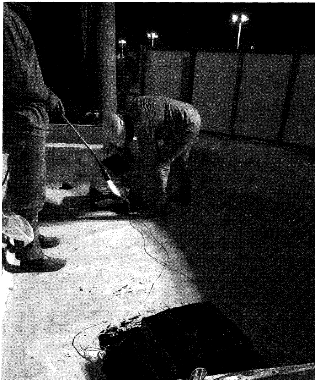
IMPERMEABILIZAÇÃO DA LAJE DO HALL DE ACESSO PRINCIPAL.
