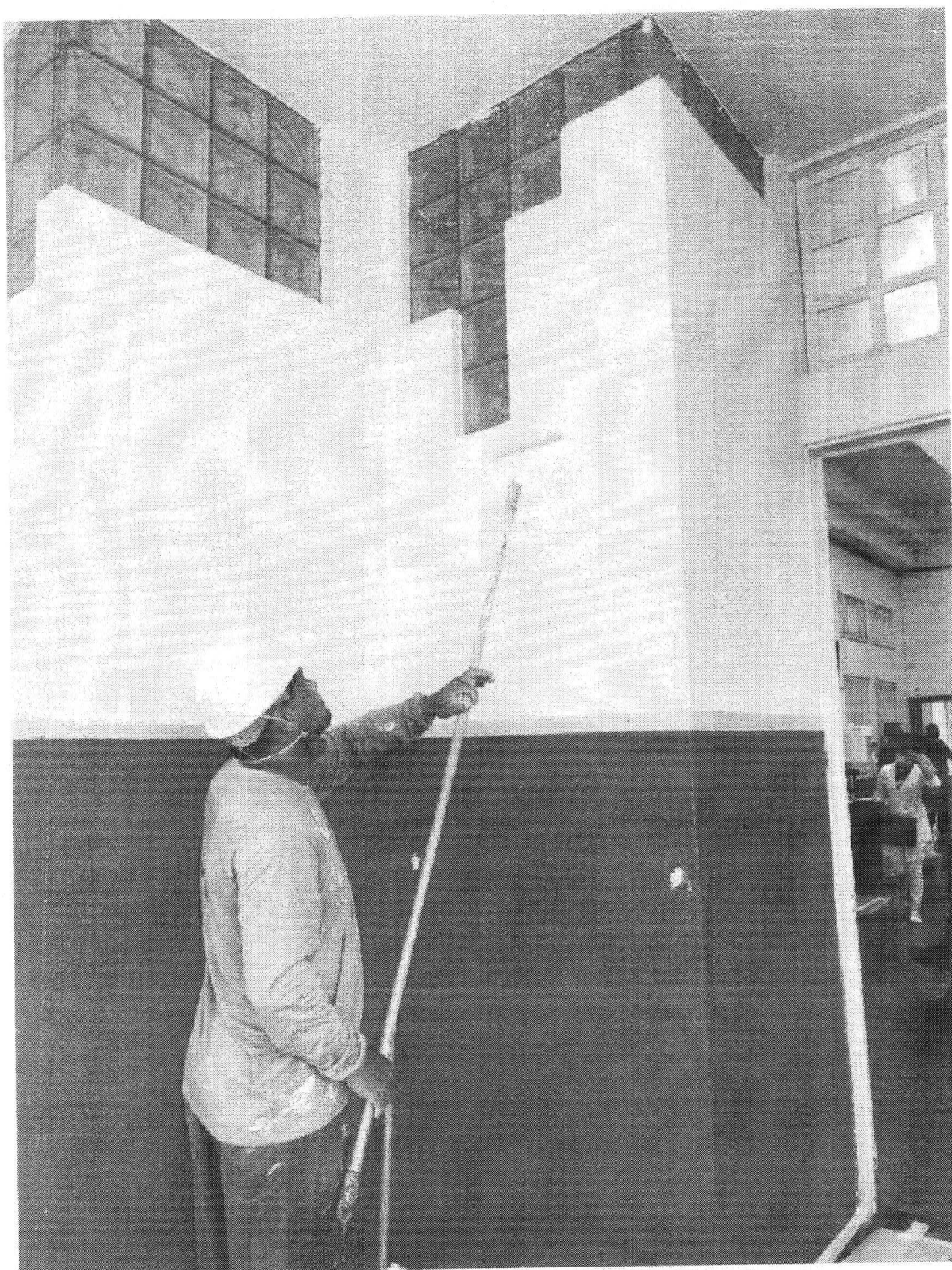
RETOQUE GERAL DA PINTURA DA FACHADA
