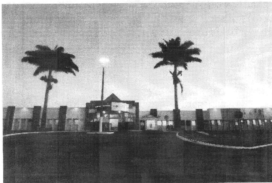
Fachada frontal atual
