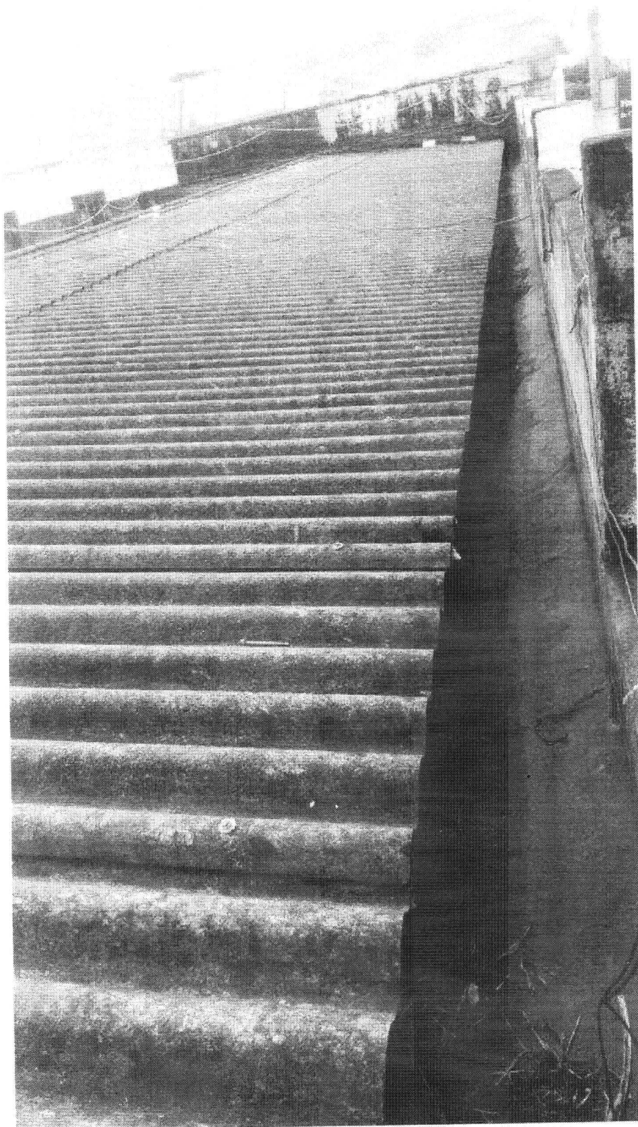
DESOBSTRUÇÃO E LIMPEZA DE CALHAS
