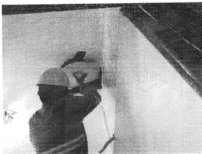
VEDAÇÃO DE ABERTURAS NO TETO
