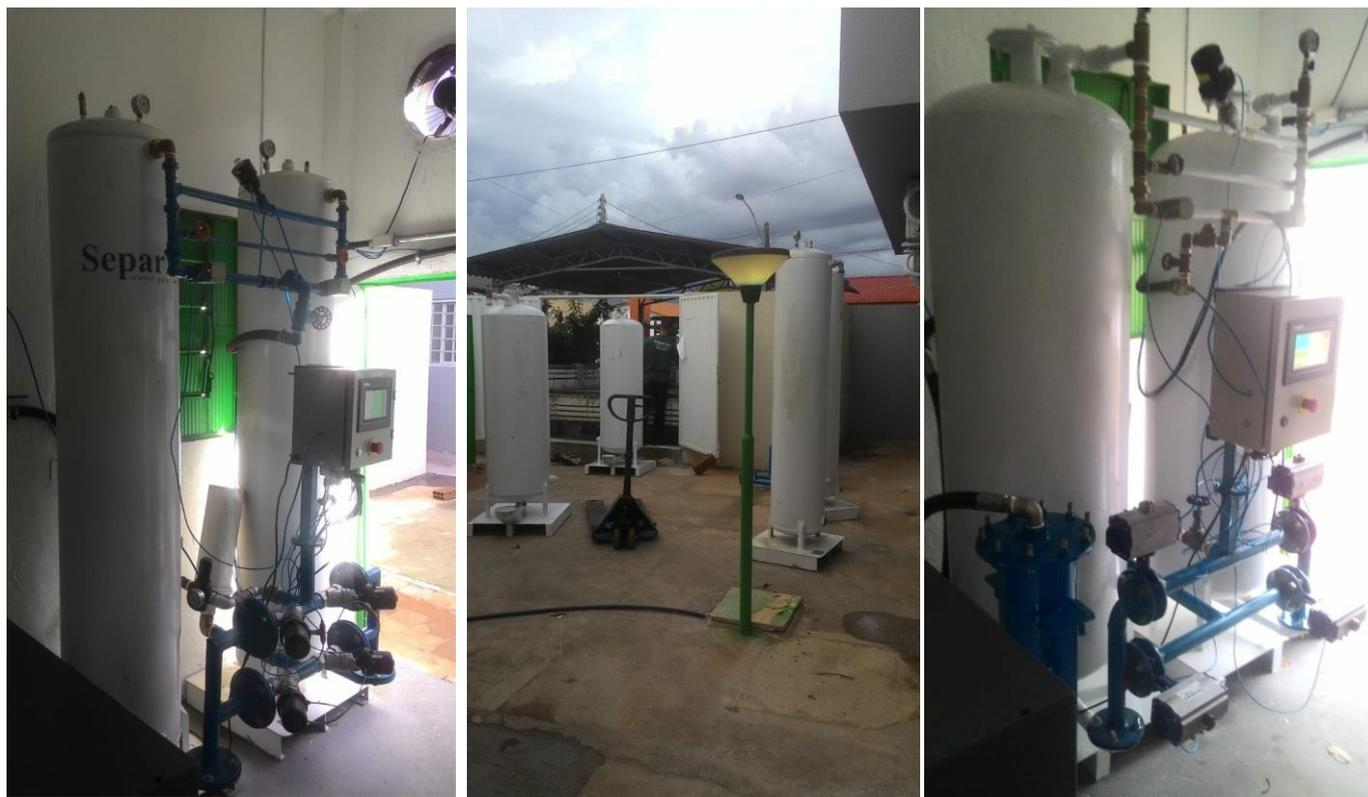
Foto 5. Substituição da usina de oxigênio, aumentando a capacidade instalada de produção de 12m<sup>3</sup>/hora para 20m<sup>3</sup>/hora.
