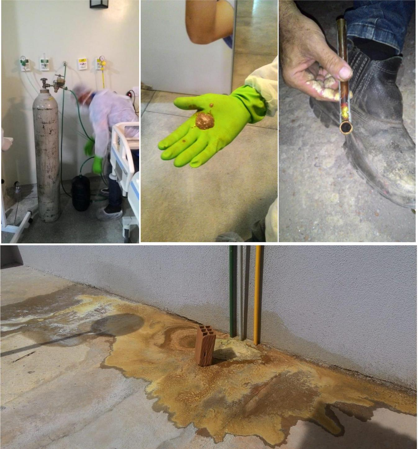
Foto 4. Limpeza de toda rede de vácuo da Unidade de Terapia Intensiva, que estava entupida.
