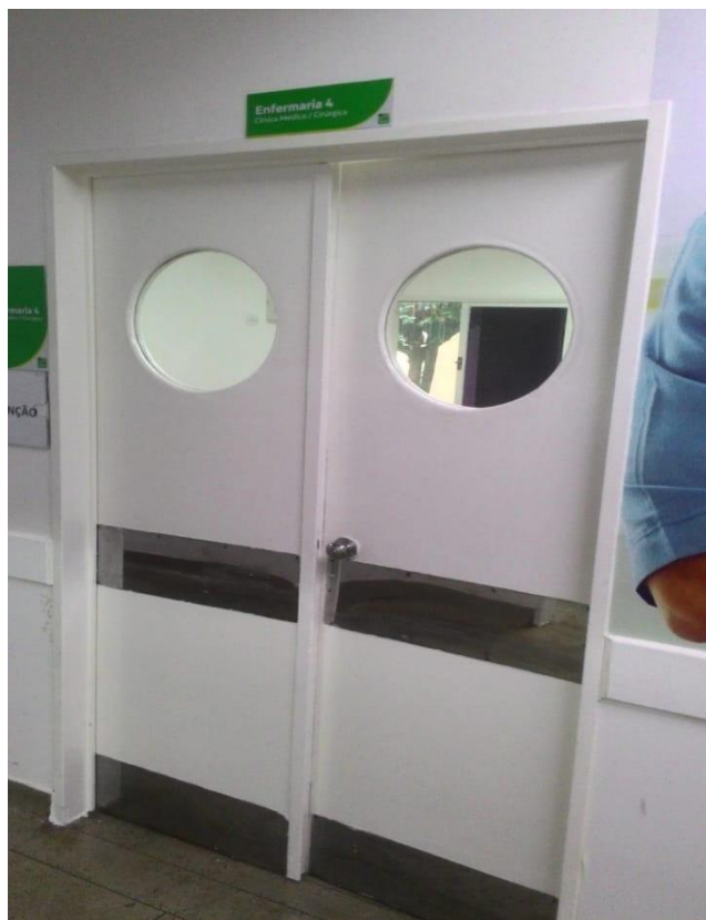
Foto 2. Porta e banheiro da enfermaria 5 após reforma.
