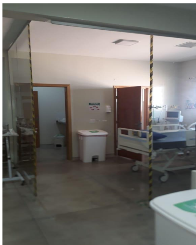
Foto 3. Retirada de 2 placas de vidro do leito de isolamento da Unidade de Terapia Intensiva, uma vez que devido a uma limitação estrutural da unidade, não era possível manobrar maca para admissão de novos pacientes. Assim, possibilitou-se o pleno funcionamento dos 10 leitos de tratamento intensivo.
