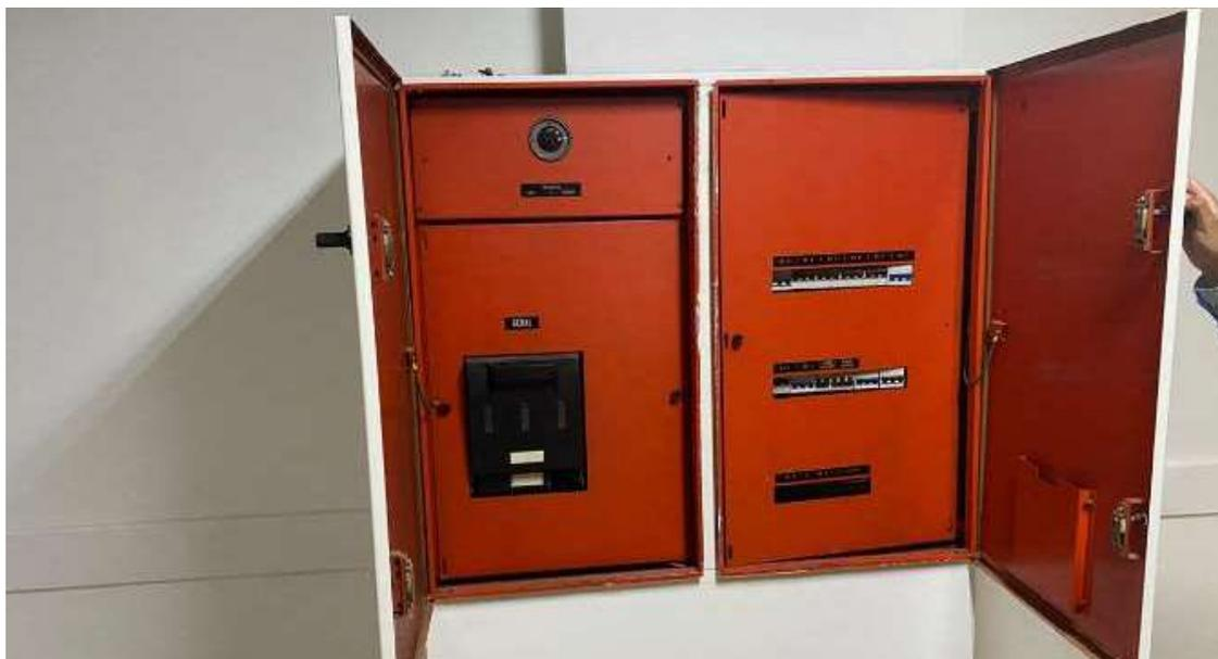
Quadro Geral sem identificação e com disjuntores fora de norma
