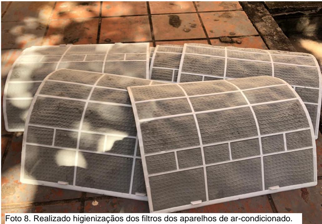
Foto 8. Realizado higienizações dos filtros dos aparelhos de ar-condicionado.
