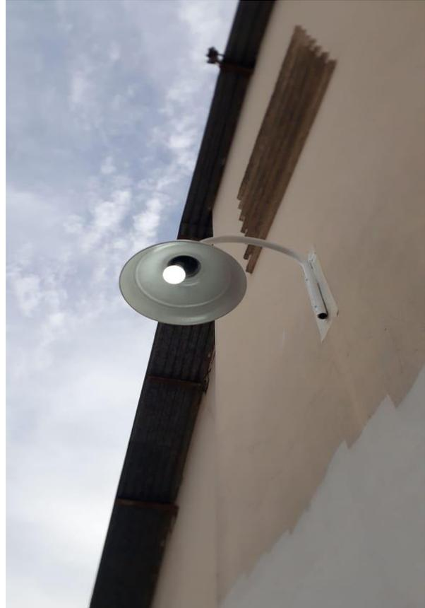
Foto 13. Substituição do soquete antigo e luminária funcionando.
