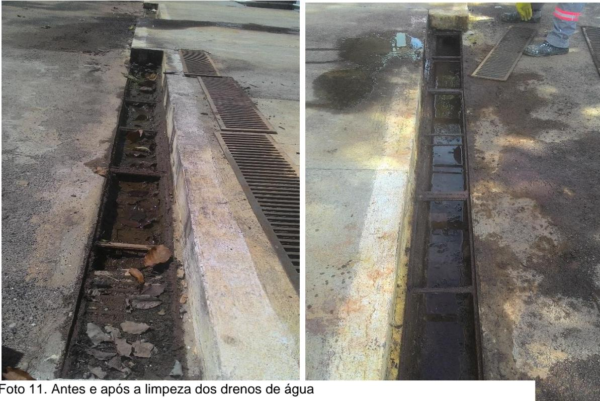
Foto 11. Antes e após a limpeza dos drenos de água
