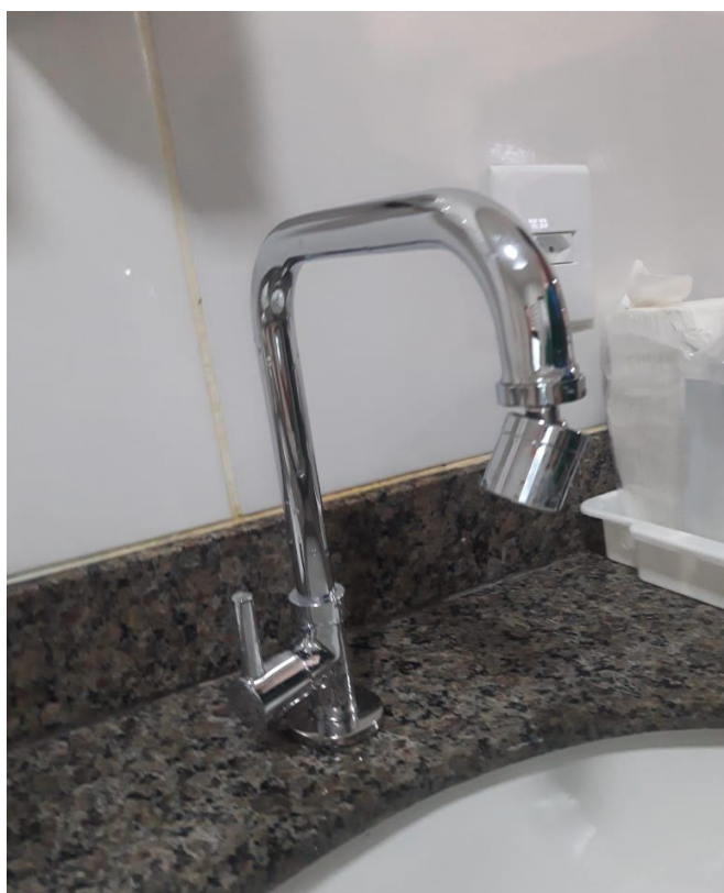
Foto 5. Torneira substituída na UTI.
