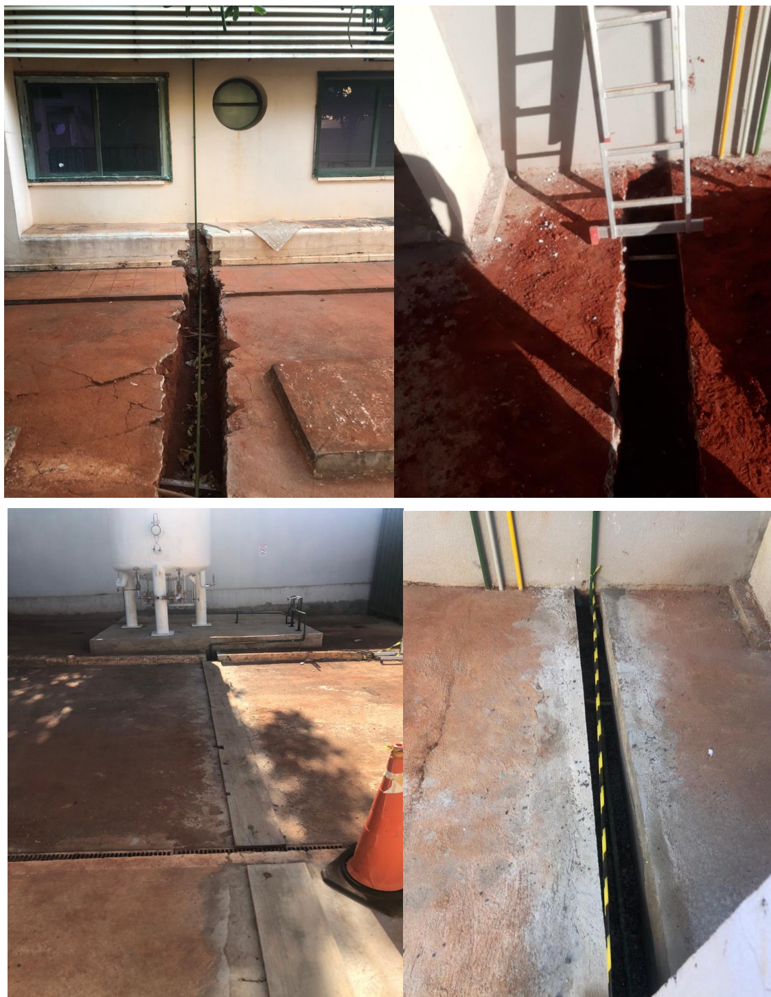
Foto 2. Cavas abertas para passagem da rede de oxigênio, interligando o tanque a rede.
