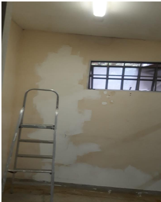
Foto 4 Revitalização da pintura do corredor da lavanderia.
