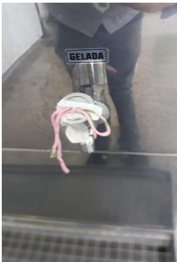
Foto 11. Substituição de torneira do bebedouro.
