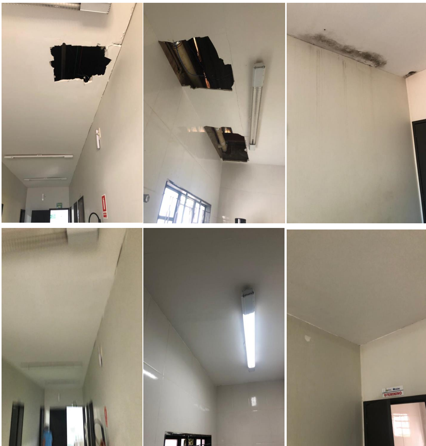
Foto 3. Reforma em forro de gesso do laboratório
