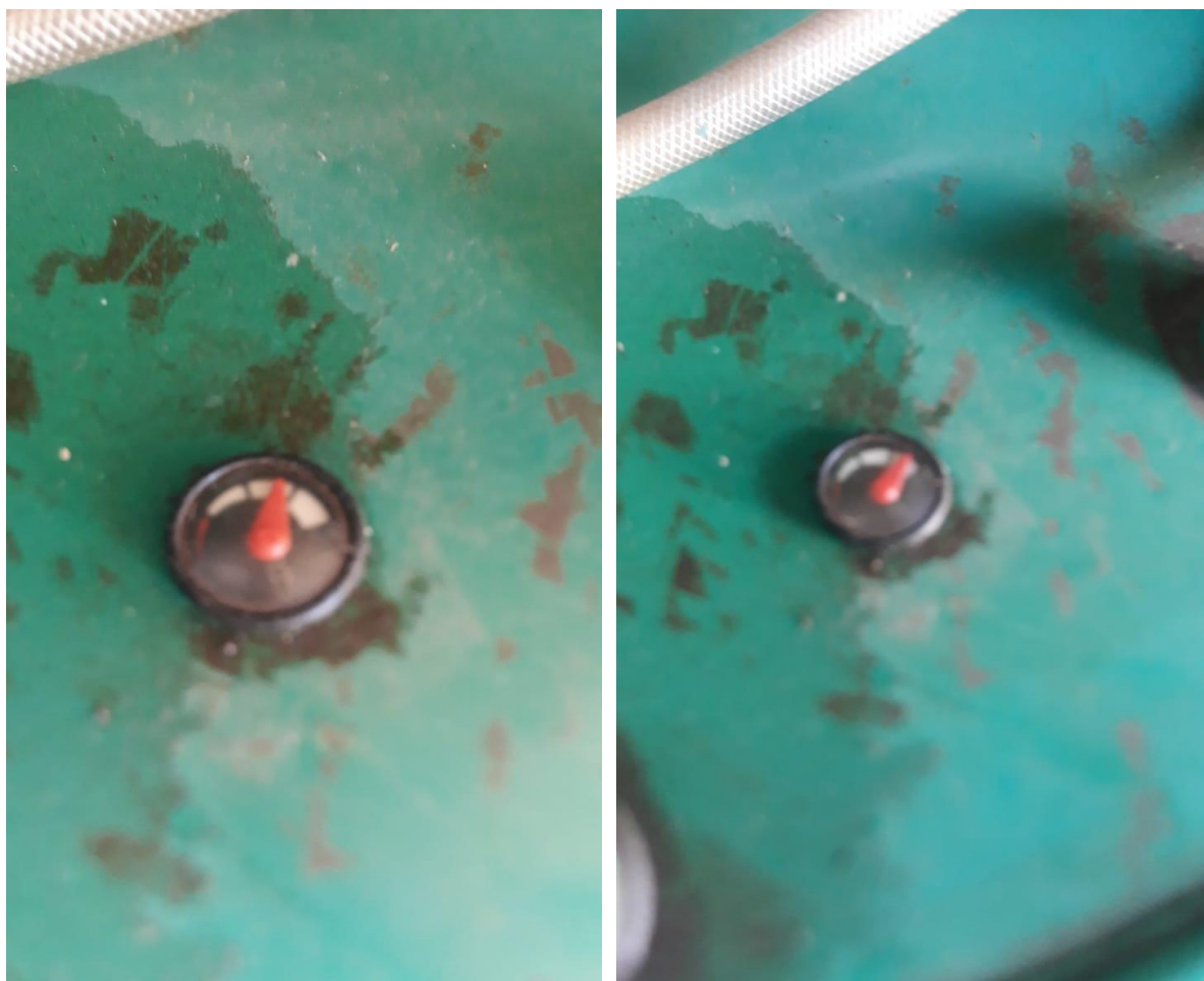
Foto 13. Acompanhamento do gerador de energia elétrica.
