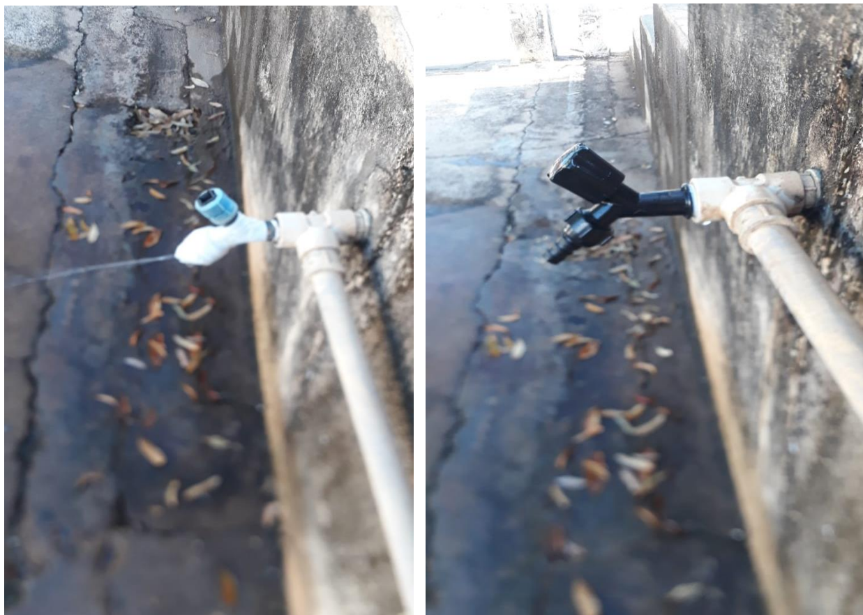
Foto 10. Substituição de torneira do estacionamento.
