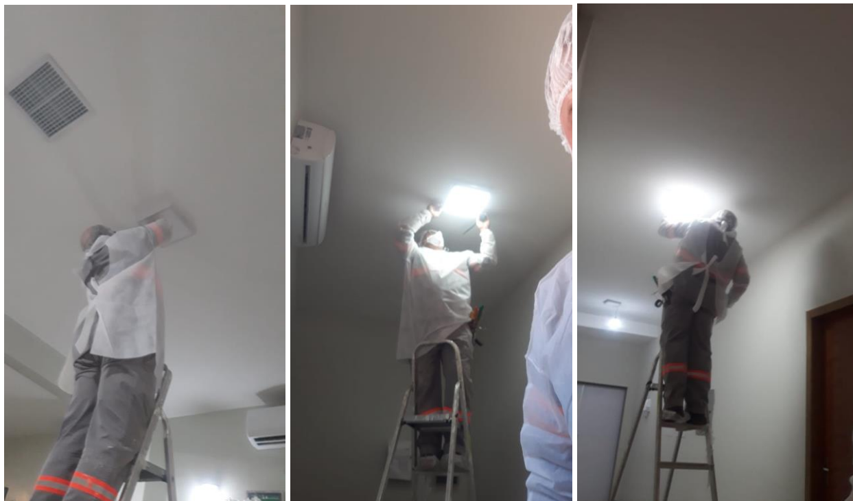
Foto 9. Substituição de 7 lâmpadas na UTI.
