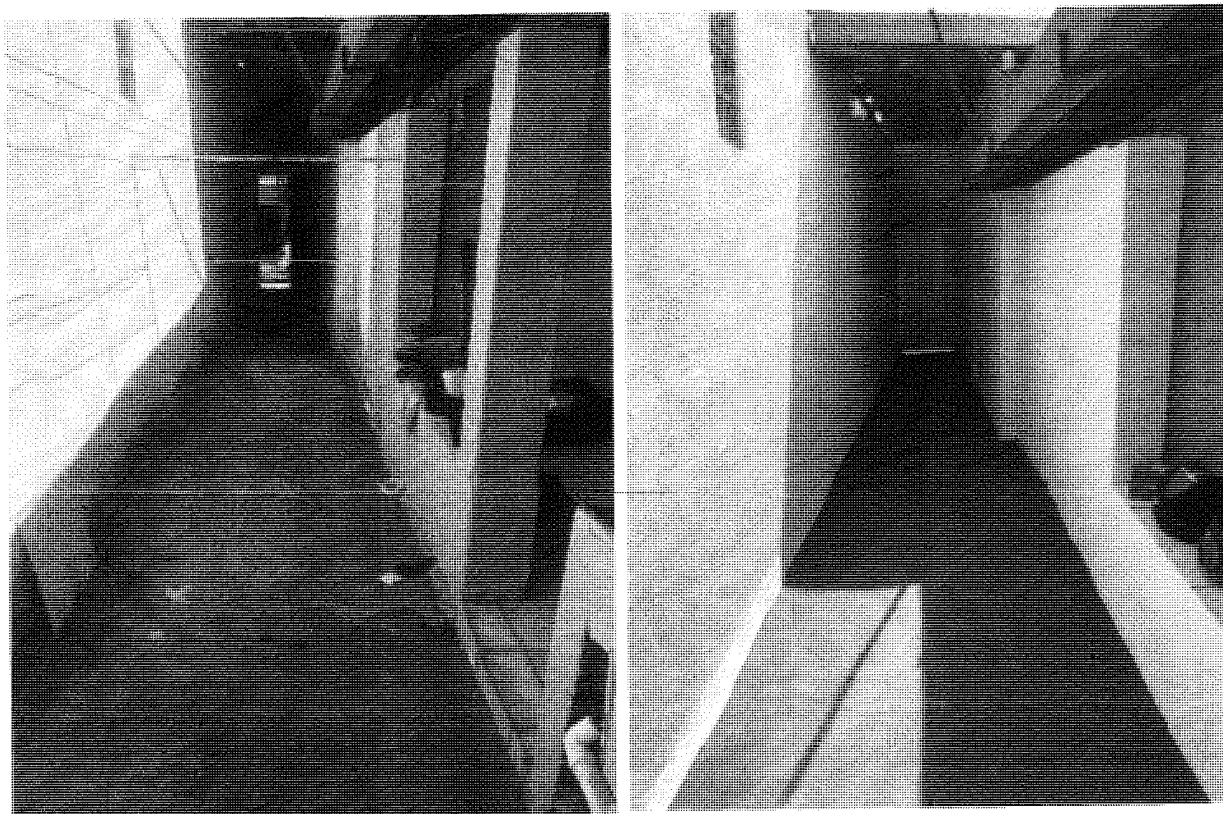
Figura 17. Antes e após pintura no corredor da casa alugada.
