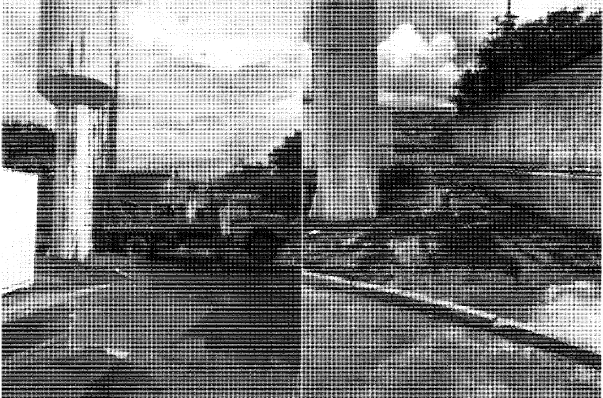
Figura 8. Perfuração de poço artesiano.
