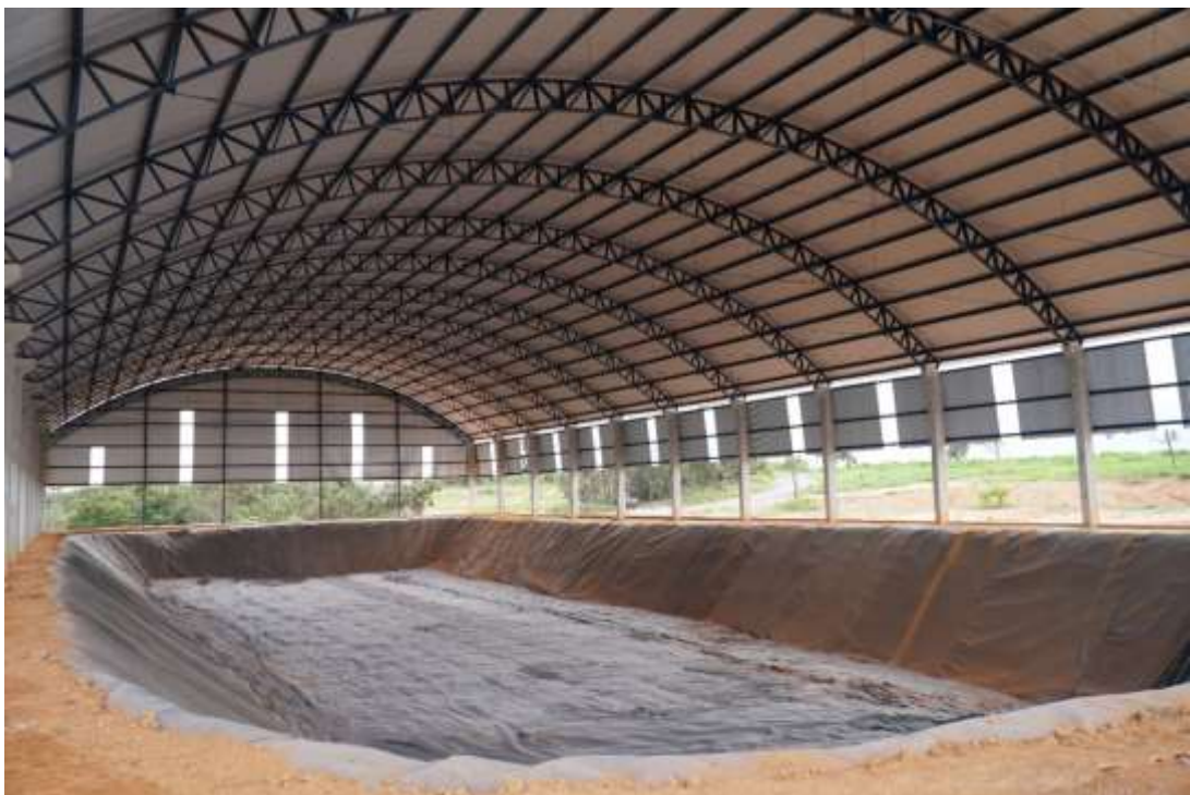
(Imagem 1 e 2: Célula de disposição final de resíduos perigosos Classe I)
